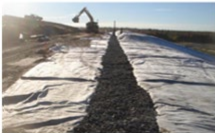
Photo : tranchée horizontale
