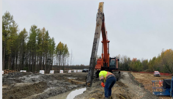
Photo : Tranchée pour le mur sol-bentonite
