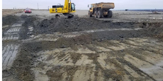
Photo : travaux d'exploitation de la phase 2
